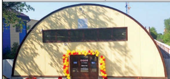
СКЛАДСКИЕ И ПРОИЗВОДСТВЕННЫЕ ПОМЕЩЕНИЯ
