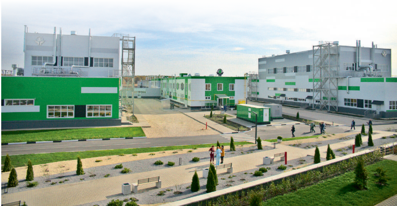
Завод «Шанс Эntерпрайз»
